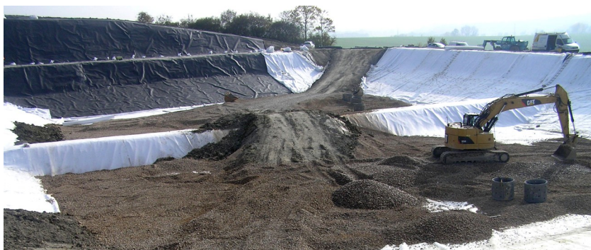
Mise en place de la « géomembrane » (membrane plastifiée étanche)
